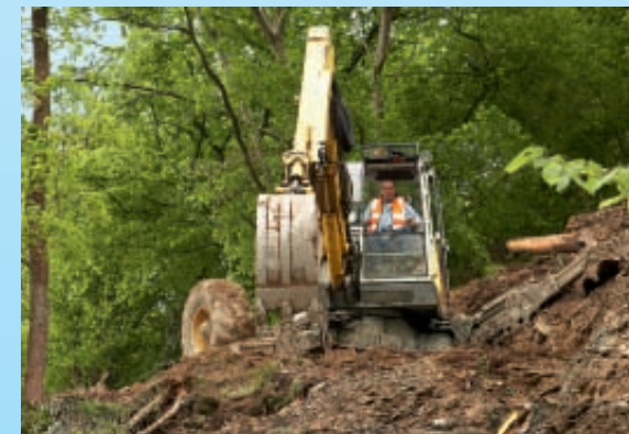
Schwieriges Gelände erfordert Spezialmaschinen: In steilen Hanglagen kommt ein Schreitbagger zum Einsatz.
