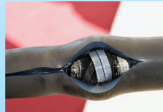
Per Kabeldiagnose kann der Gesamtzustand einer Leitung beurteilt werden.
