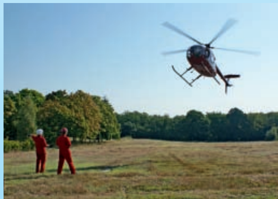
Zu nah an die Freileitung herangewachsene Bäume werden bei Bedarf per Hubschrauber gekürzt.
