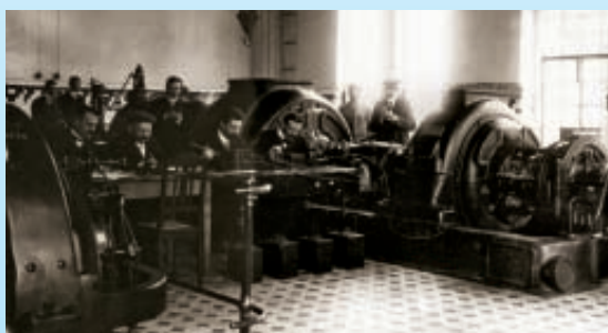
1.200-PS-Dampfturbine im Kreuznacher Elektrizitätswerk.
