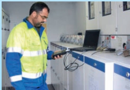
RWE-Monteur Stephan Sturm überprüft eine Schaltanlage.
